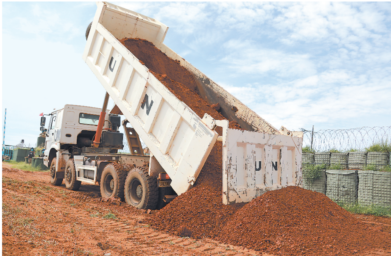
当地时间10月8日，我第8批赴南苏丹维和工兵分队高标准完成加奥超级营地北门道路和营区内主干道修复改造任务，保障了各国维和部队车辆装备顺畅通行。图为施工现场。 王立军摄
