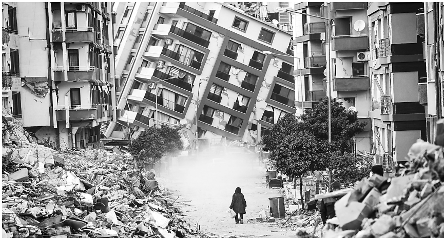
当地时间17日，在土耳其南部哈塔伊省，一名女子行走在震后的废墟中。作为此次地震重灾区，当地不少建筑受损严重。（IC photo）
