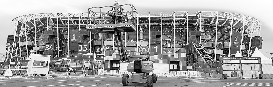
当地时间12月7日，卡塔尔世界杯比赛场地974体育场拆除工作开始。该体育场使用回收的集装箱建造，拆除后，所有集装箱将被捐赠给有需要的国家。（视觉中国）
