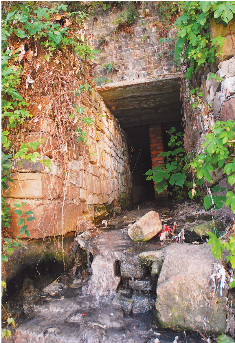
福寿沟始建于北宋熙宁年间，依街道布局，地形特点，建成“福沟”和“寿沟”两个排水干道系统，并与整个城市的水塘连接，暴雨时可调节流量，减少下水道溢流，而干道系统则利用城市地形的高低差，把自然降水和生活、废水排入江中，形成消涨自然闭合的系统。图为在章江的古城墙外墙上拍摄的福寿沟出口的情景。
